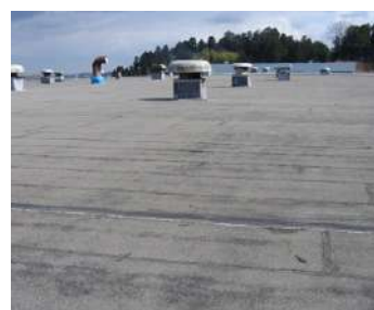
31年経過したタフネス防水(2010年)
