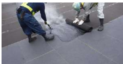
シートの張付け状況
