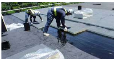
断熱材の張付け状況
