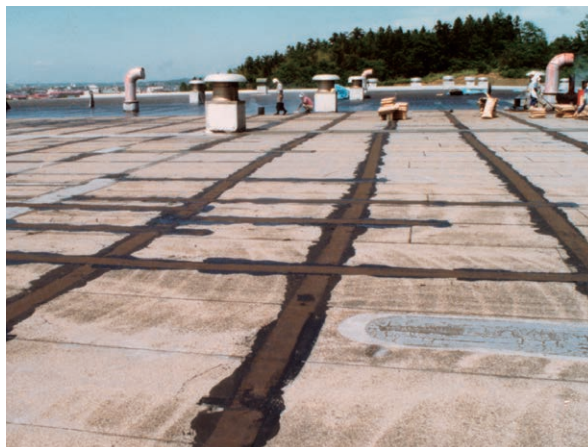
ALC下地 ALCパネル短辺の増張り状況(1979年増築部)
