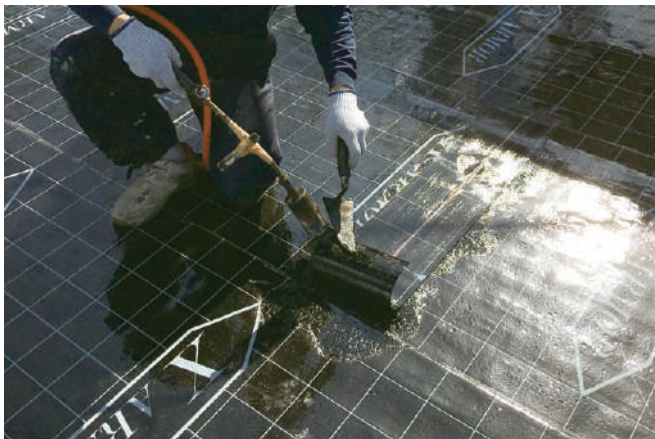
クロスアーマーベース短辺突付け部の増張り処理
