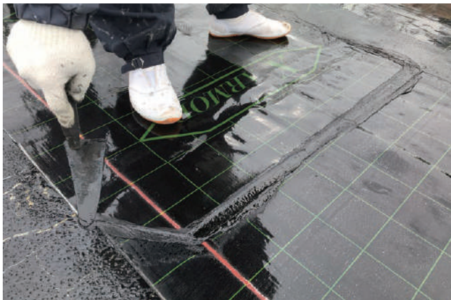
クロスアーマーシールド短辺ラップ処理
