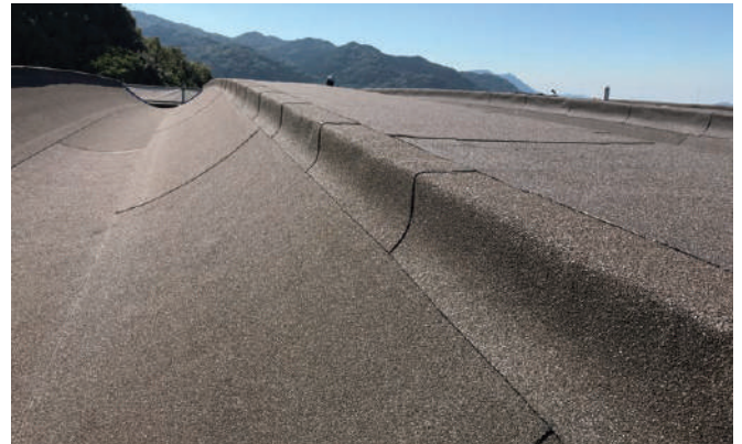
シート張付け完了
