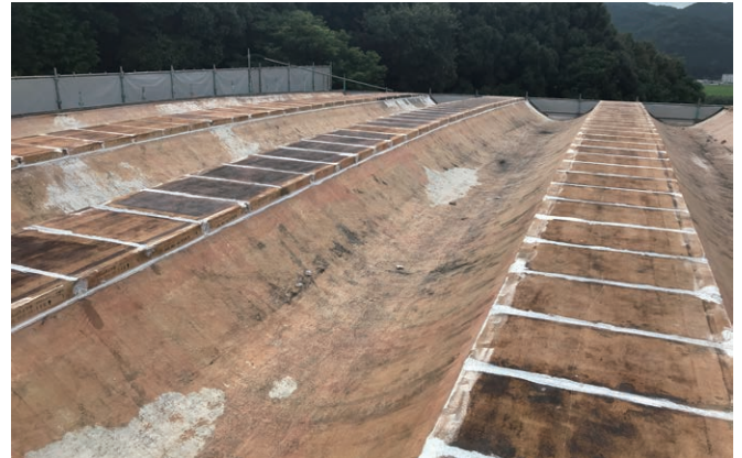
既存防水層撤去
