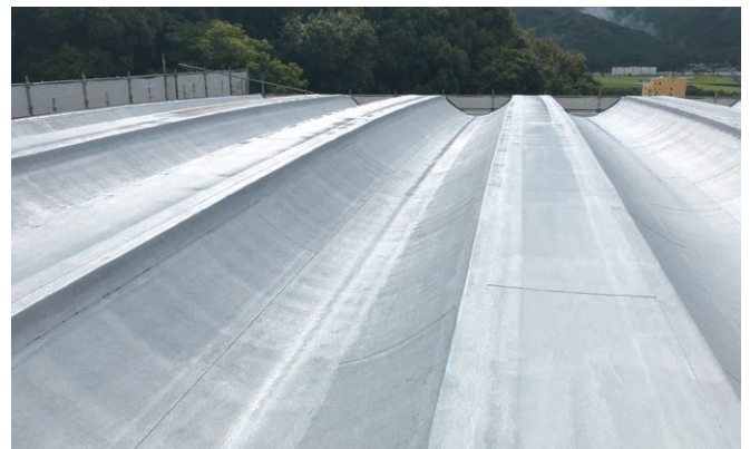
保護塗料塗布完了
