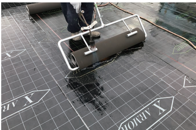
クロスアーマーシールド張付け
